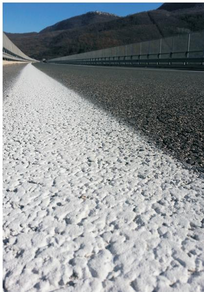
Esecuzione di segnaletica orizzontale con vernice spartitraffico rifrangente del tipo premiscelato o con successiva post - spruzzatura di microsfere di vetro ai fini di una rifrangenza maggiore.
