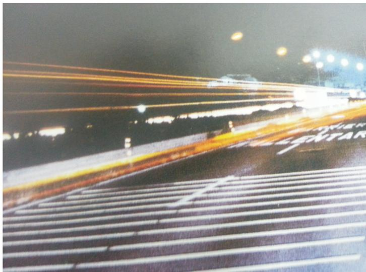
Le Bande Sonore sono realizzate in laminato elastoplastico rifrangente ed antisdrucchiolo e vengono installate perpendicolare al senso di marcia.
