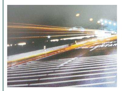
Le Bande Sonore sono realizzate in laminato elastoplastico rifrangente ed antisdrucciolo e vengono installate perpendicolare al senso di marcia.
